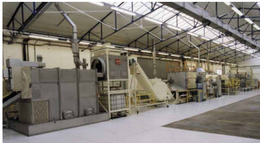
Ligne de traitement thermique automatisée
